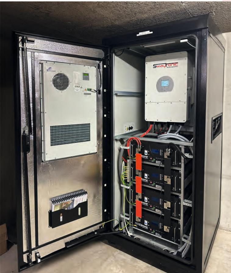
Der Energiespeicher speichert die überschüssige Solarenergie unserer Photovoltaikanlage.
